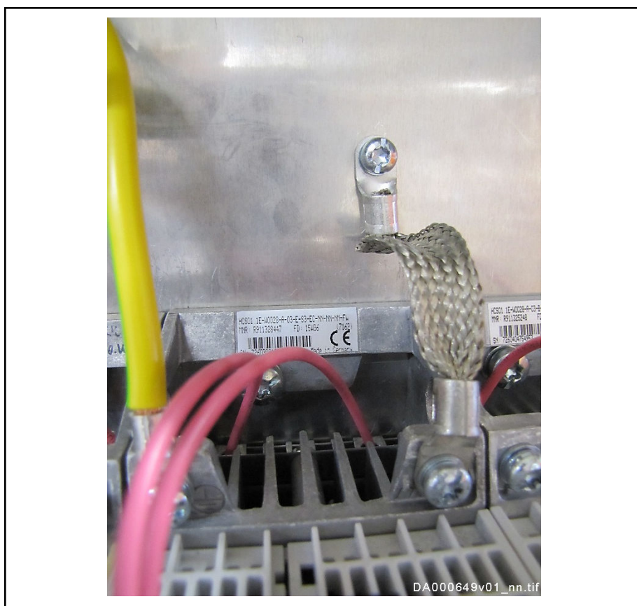
Abb. 6-26: Masseband zwischen Kühlkörper und Montagefläche (Beispiel)
